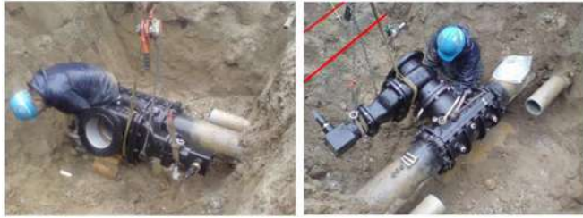
1.斜め穿孔用弁据付中 ① 2.斜め穿孔用弁据付中 ②
