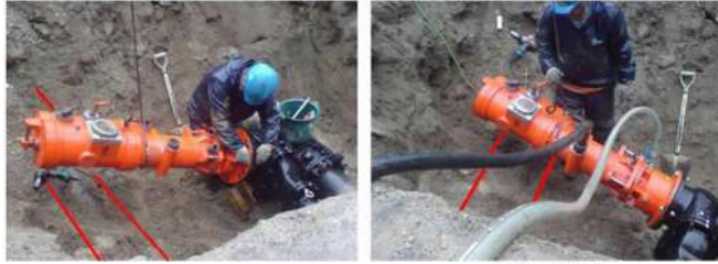
3.穿孔機据付中 4.穿孔中
