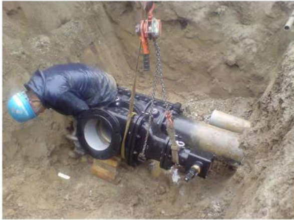
1.斜め穿孔用弁据付中 ①
