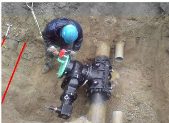
5.斜め穿孔用弁水压検査中 ①
