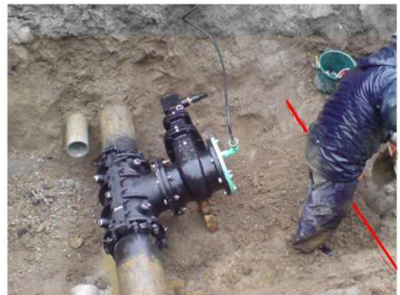
6.斜め穿孔用弁水压検査中 ②
