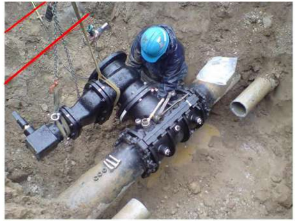
2.斜め穿孔用弁据付中 ②
