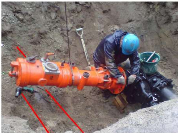
3.穿孔機据付中
