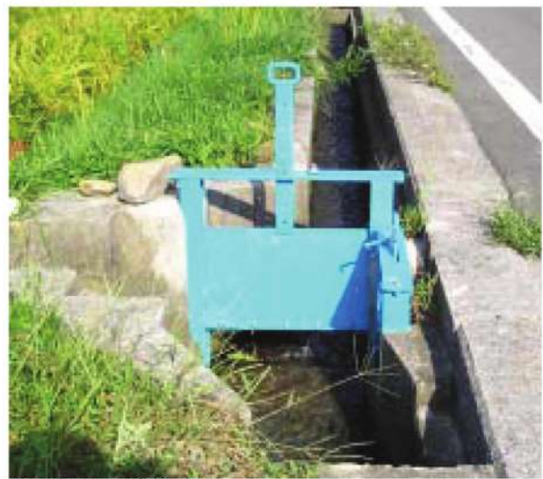
鋼製手上げゲート
