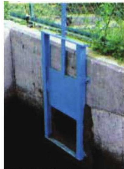
鋼製手上げゲート
