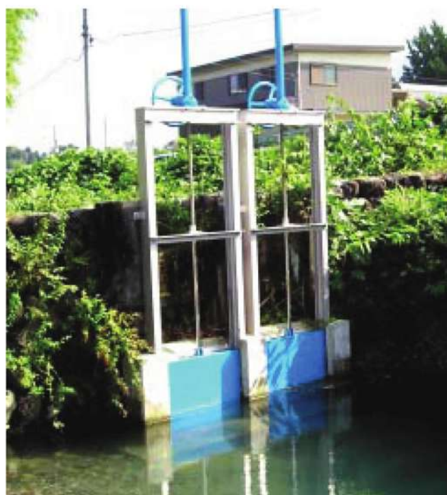
鋼製簡易スルースゲート(ベベル式)
