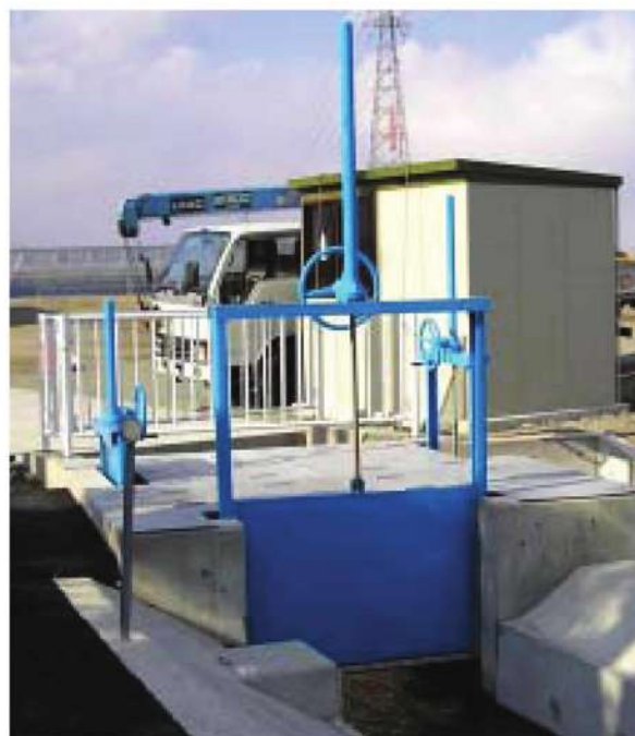
鋼製簡易スルースゲート(ベベル式)
