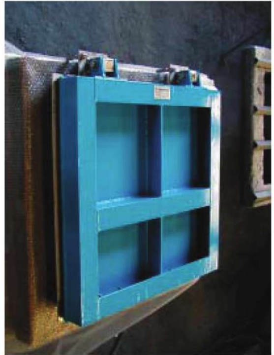
鋼製フラップゲート
