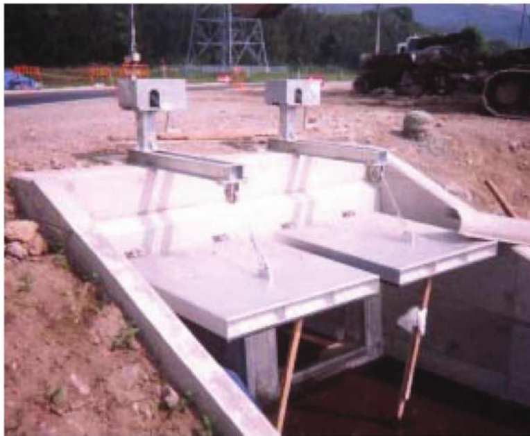
ステンレス製フラップゲート（巻上機付）
