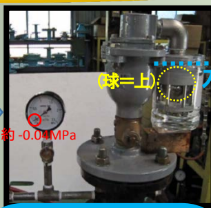
水没状態で負圧を作出し、水の吸込みがないかチェック!
