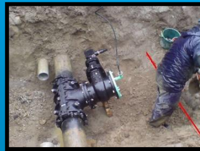
リクライニング仕切弁斜め設置完了
