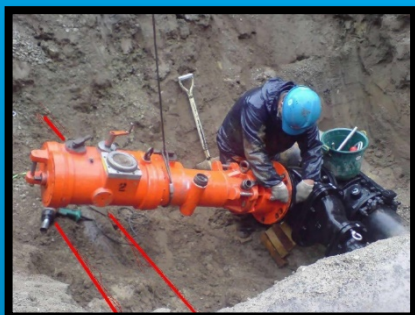
リクライニング仕切弁に穿孔機設置中
