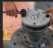
挿入 3 挿入後ボルトナットを締めて施工完成
