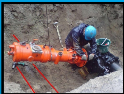
リクライニング仕切弁に穿孔機設置中
