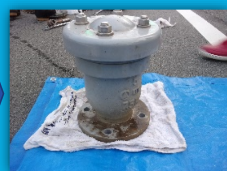
空気弁撤去
