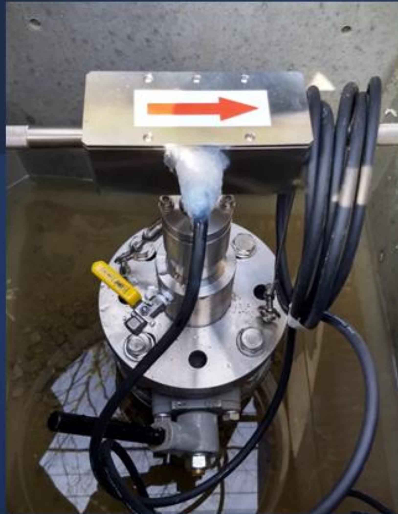
挿入式超音波流量計
